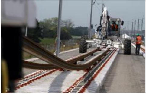
La pose des longs rails soudés a commencé à Vieux-Lixheim sur 106 km de ligne entre Baudrecourt et Vendenheim. Les rails sont déchargés par un ensemble composé d'un wagon pousseur et d'une pelle de guidage. Photo Bruno ESTRADA
