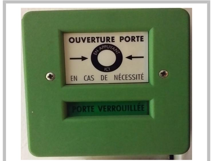
Ce bouton est systématiquement posé à côté d'une porte à ouverture électrique (portes coulissantes, à contrôle par badge, etc.).
